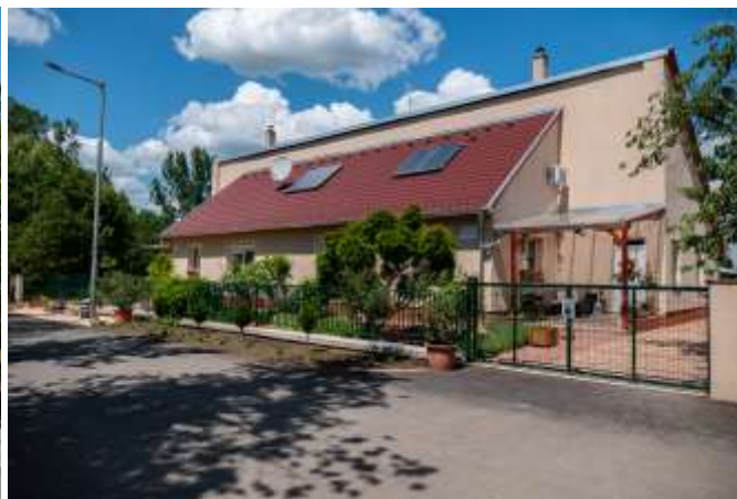
A felújított szolgálati lakások.
