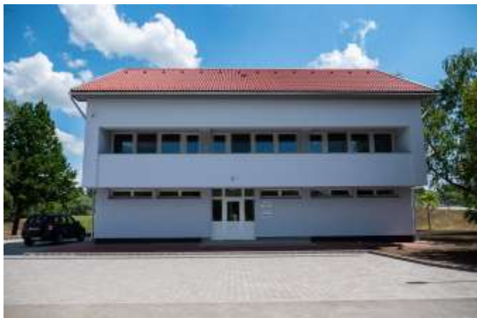
Az elkészült üzemviteli épület.
